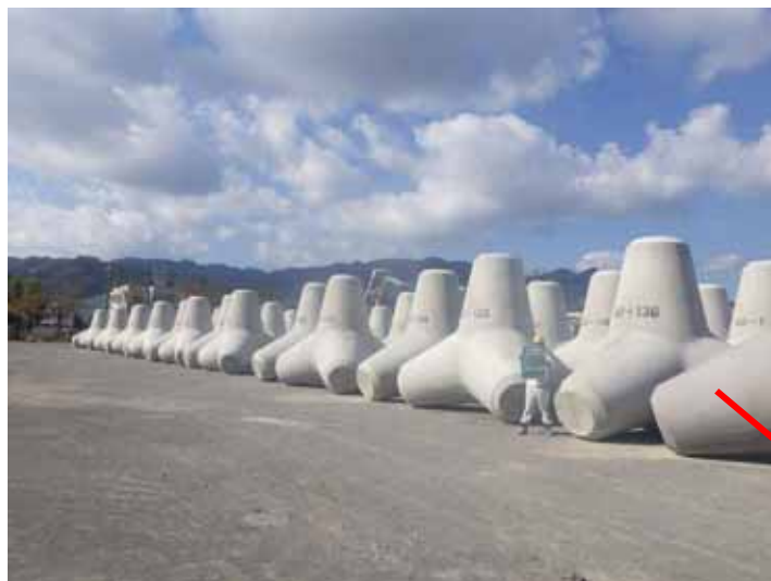
【2号消波堤復旧 消波ブロック製作】
