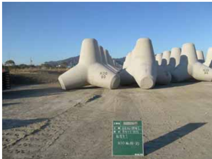
【2号消波堤復旧 消波ブロック製作】
